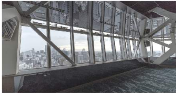
天井一面と腰壁をダークミラーで覆った展望台
