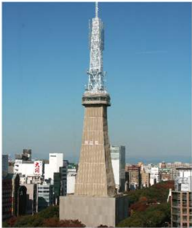
足場を組みスカート状に防塵シートが掛けられたテレビ塔
