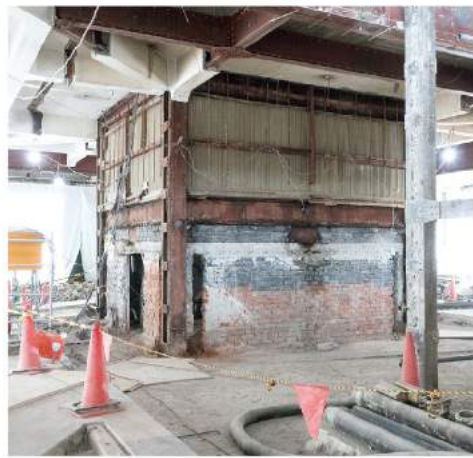
エレベーター室の下から現れたレンガ壁
