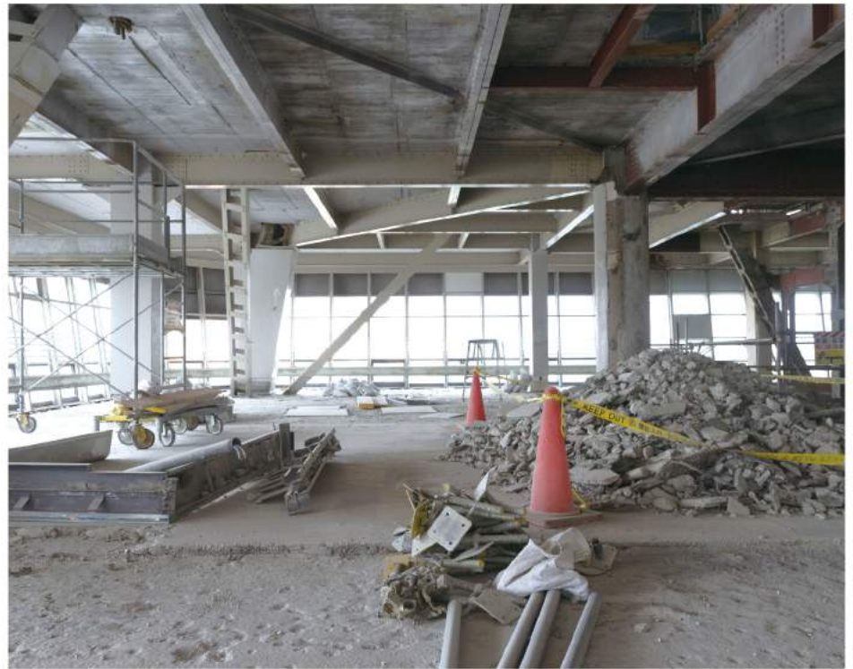
解体工事中の建屋。がらんとした塔内にはとところろ穴が空き配線などが埋められていた床(バサ)が掘り返されている
