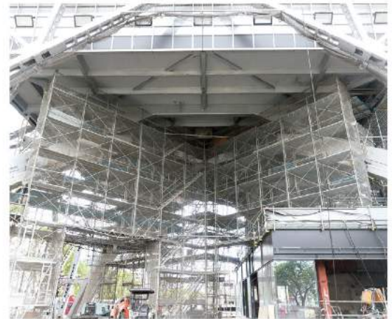
交差アーチに沿って設けられた作業用足場
