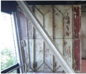
間仕切りに再利用された鉄製の旧防火扉
